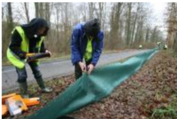
Installation d'un crapauduc provisoire par l'ONF © ONF
